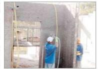
A argamassa é jateada sobre os painéis com ajuda de uma máquina especial. Após secagem, uma nova camada é aplicada
